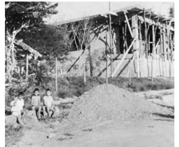
Casa da Rua Silvério Ribeiro sendo construída
