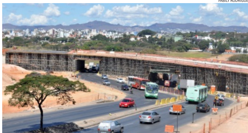
Obras do novo viaduto da Pedro I com Portugal estão adiantadas e dão uma nova "cara" à Barragem da Pampulha, que já conta com as pistas exclusivas do BRT
