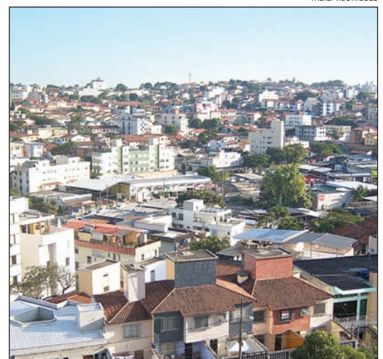
Foto feita na rua Leopoldina Cardoso com vista panorâmica para a avenida Sebastião de Brito e bairros Dona Clara e Jaraguá, onde há um significativo predomínio de prédios
